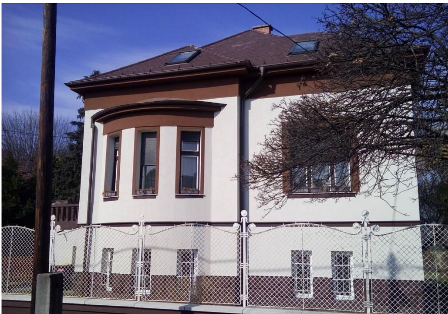
Az eredeti tömeg, tetőforma, homlokzat tagolás megtartásával felújított épület.
