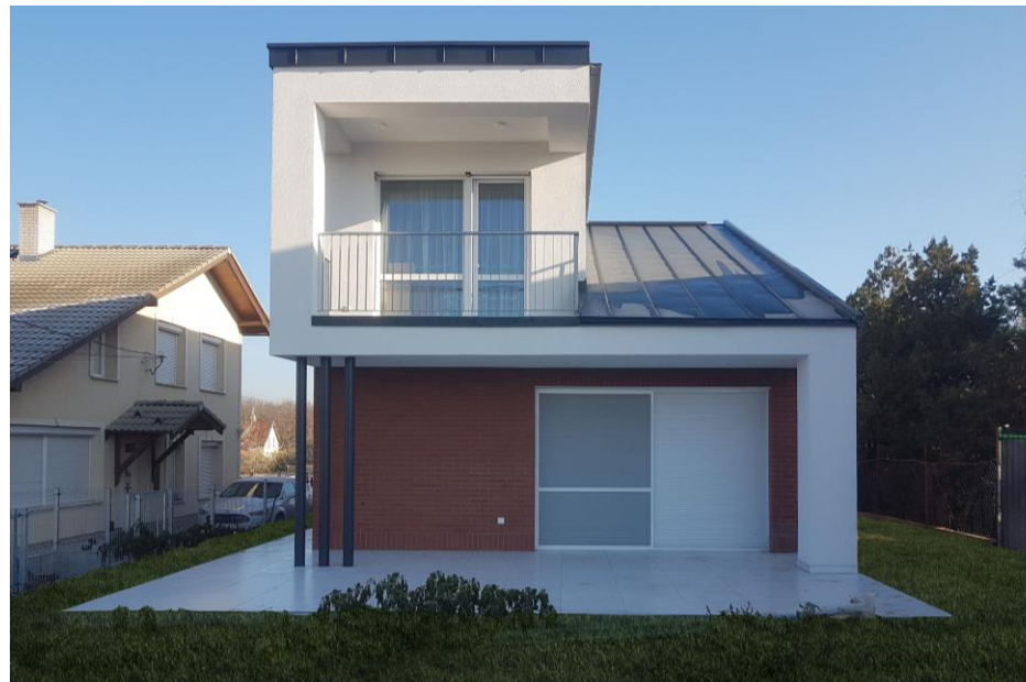
Magas-és lapostető vegyes alkalmazása karakteres építészeti megoldást eredményezett.
