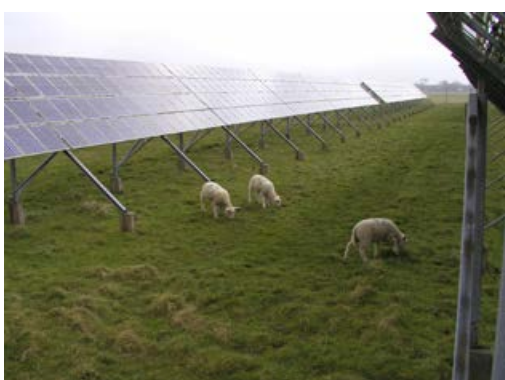
23. ábra: Birkák legelnek a fotovoltaikus rendszer sorai között (Forrás: Pellworm Solarkraftanlage, Németország)
