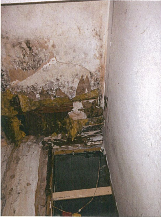
Födém szerkezet hiányos alsó deszkaborítással
