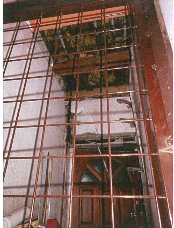
Födém szerkezet hiányos alsó deszkaborítással
