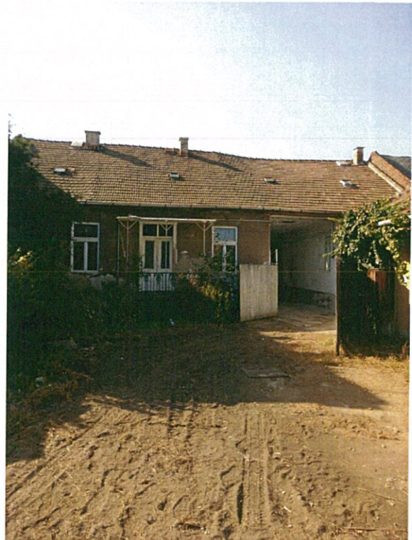
A lakóépület udvari homlokzata
