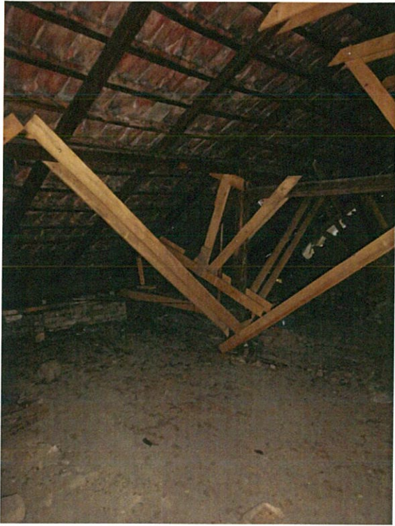
Megerősített tetőszerkezet (korábbi felvétel)
