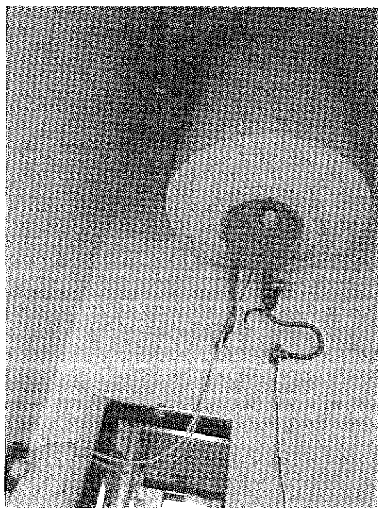
Melegvzellátást biztosító villany bojler
