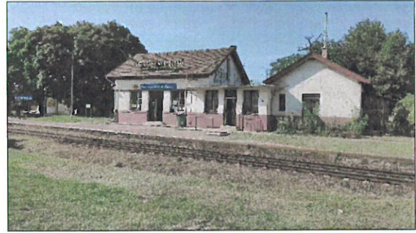
Pestszentimre felső mh. felvételi épülete
