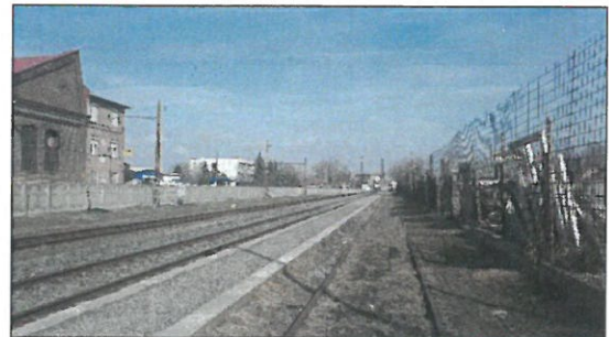
Kispest állomás vágányhálózata Budapest felé nézve
