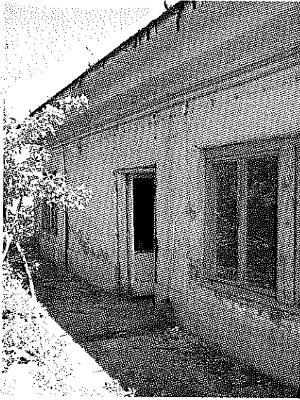
8. A 2.sz. melléképület ÉNy-i homlokzata
