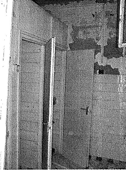
15. 3.sz. melléképület WC
