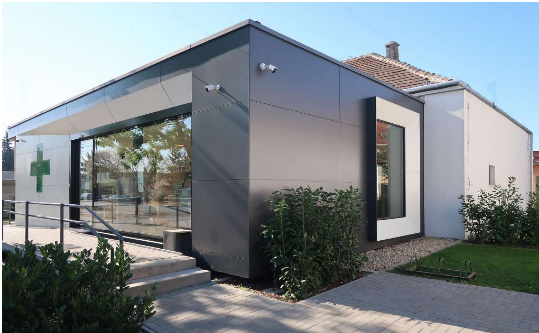
A bővítmény a meglévő épület tömegének, építészeti jellegének tiszteletben tartásával, kortárs megjelenésével üdítő színfoltként jelenik meg az Üllői úton. Példaértékű az akadálymentes közlekedést biztosító rámpa lebegni látszó kialakítása.
