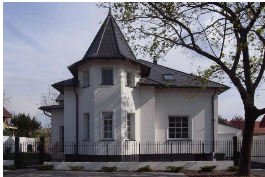
Színvonalasan felújított tornyocskás ház, letisztult, modern színezéssel.
