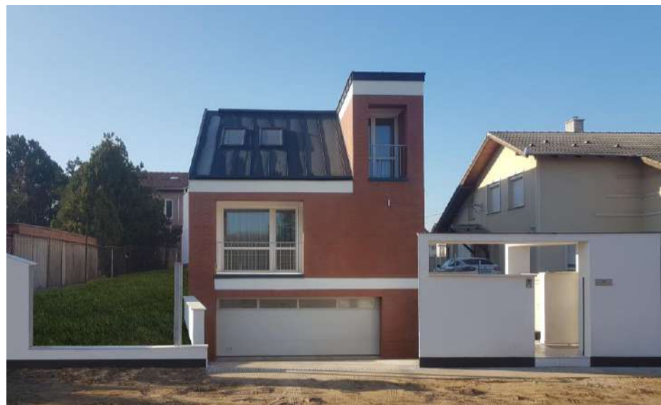
Magas-és lapostető vegyes alkalmazása karakteres építészeti megoldást eredményezett.
