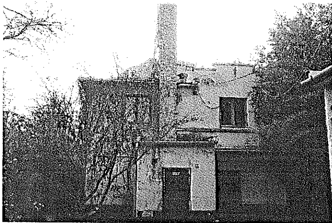
1.2. kép: üzemi épület udvar felőli homlokzata
