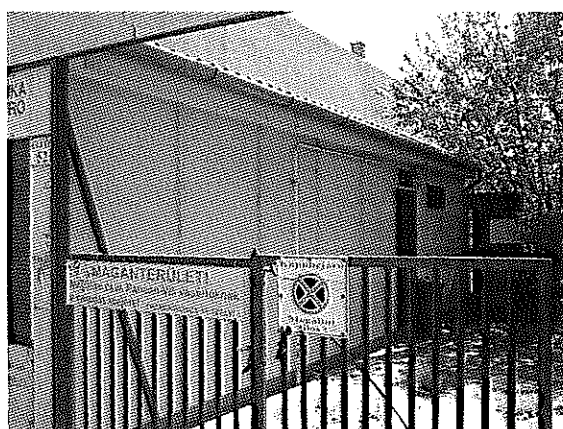
6. Az 1.sz. melléképület oldalhomlokzata
