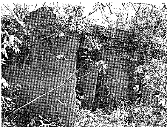
12. A 3.sz. melléképület ÉNy-i homlokzata
