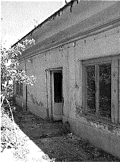
8. A 2.sz. melléképület ÉNy-i homlokzata
