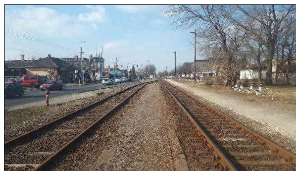
Pestszentimre állomás a kezdőpont felé nézve
