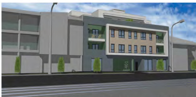
UTCAI ÁTELLENES OLDALRÓL KÉSZÜLT FÖLDSZINTI LÁTVÁNY
