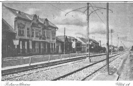
A Ledi pékség épülete
