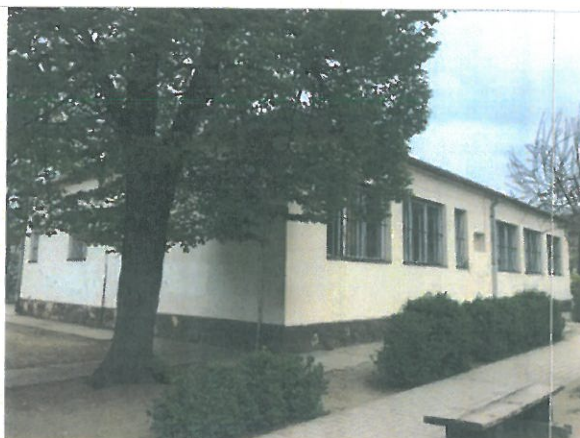
Az épület „kazánház” felé mutató homlokzata.
