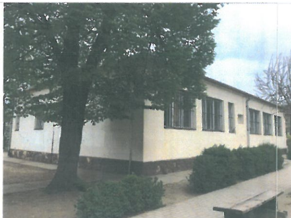
Az épület „kazánház” felé mutató homlokzata.
