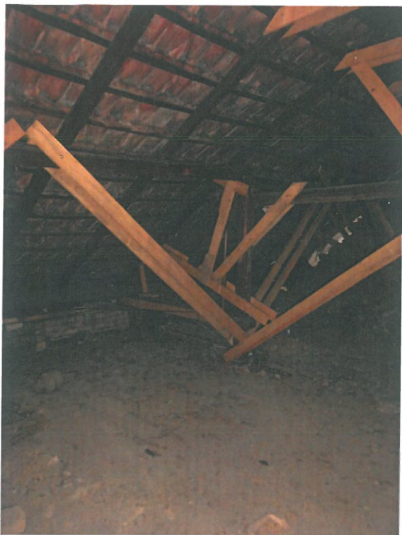
Megerősített tetőszerkezet (korábbi felvétel)
