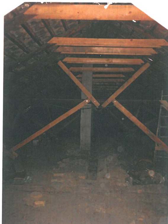
Megerősített tetőszerkezet (korábbi felvétel)
