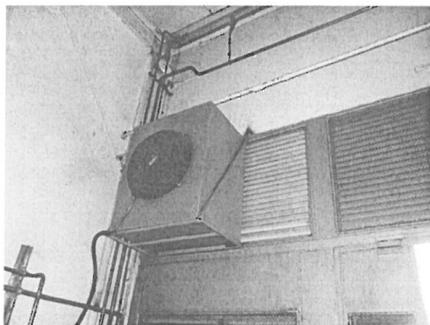
46.-Aggregátor szellőzése
