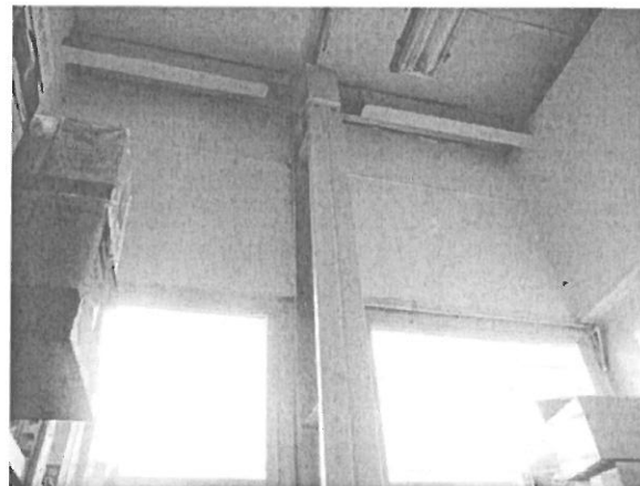
26.-Raktár-2 belső homlokzata
