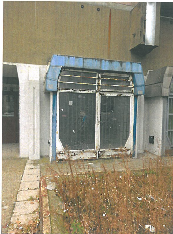
Elrozdásodott portál
