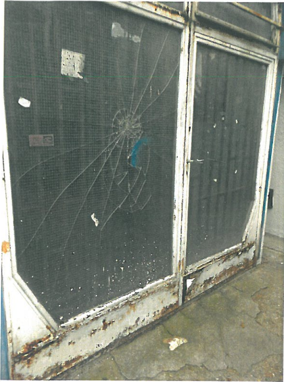
Elrozdásodott portál
