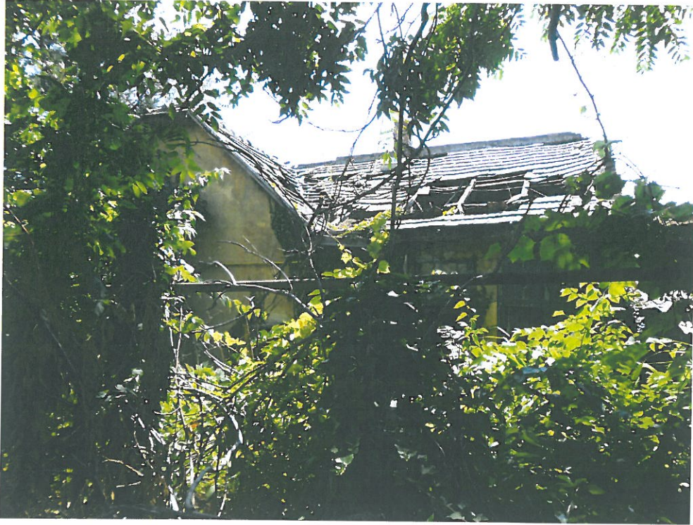
Főépület - udvari homlokzat – hiányos tető héjazat
