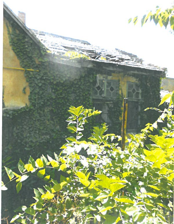
Főépület - udvari homlokzat – hiányos tető héjazat
