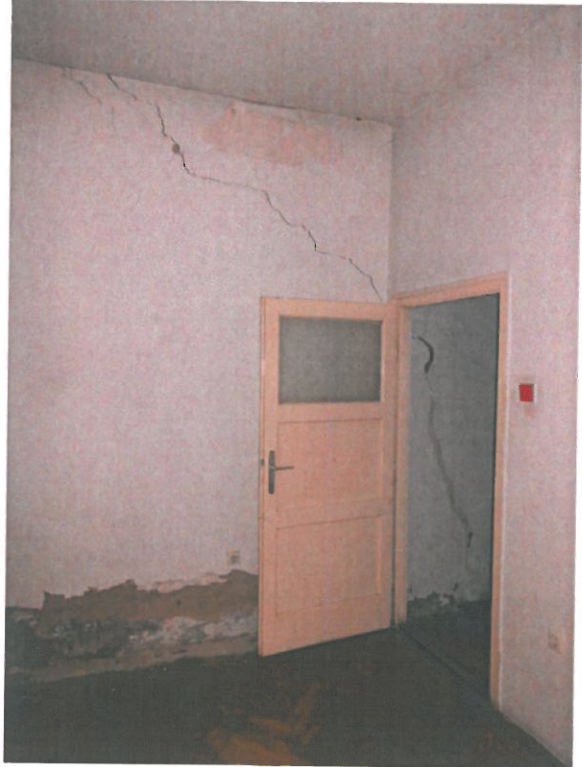
Felnedvesedet falak, süllyedésre utaló repedés
