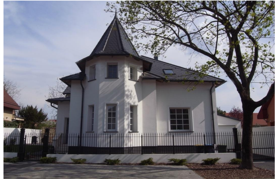
Színvonalasan felújított tornyocskás ház, letisztult, modern színezéssel.
