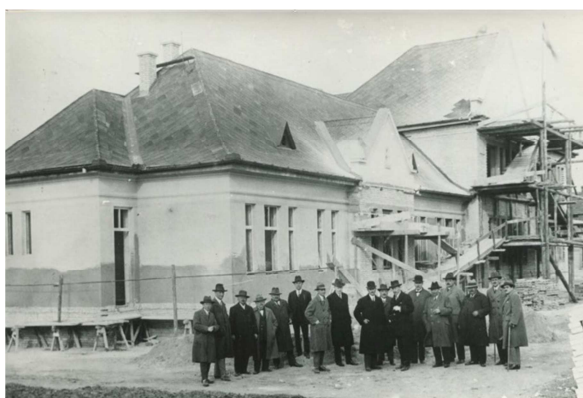
Vármegyei és községi vezetők ellenőrzik a Gulner utcai iskola építkezését
