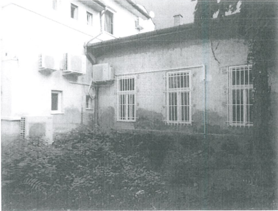
Udvari homlokzat, felnedvesedett falak, repedések
