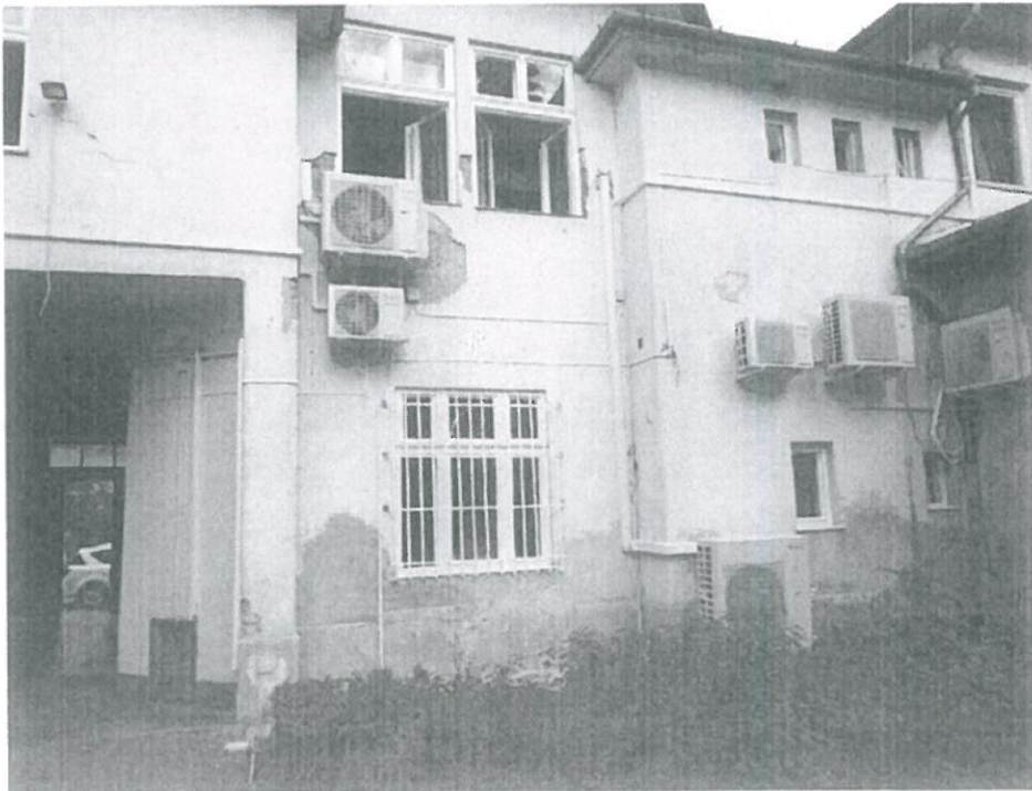
Udvari homlokzat, felnedvesedett falak, repedések
