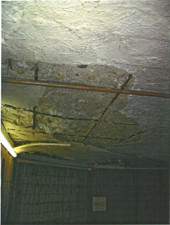
Pince földém – erősen korrodált, elcsavarodott acélgerendák és betonvasak
