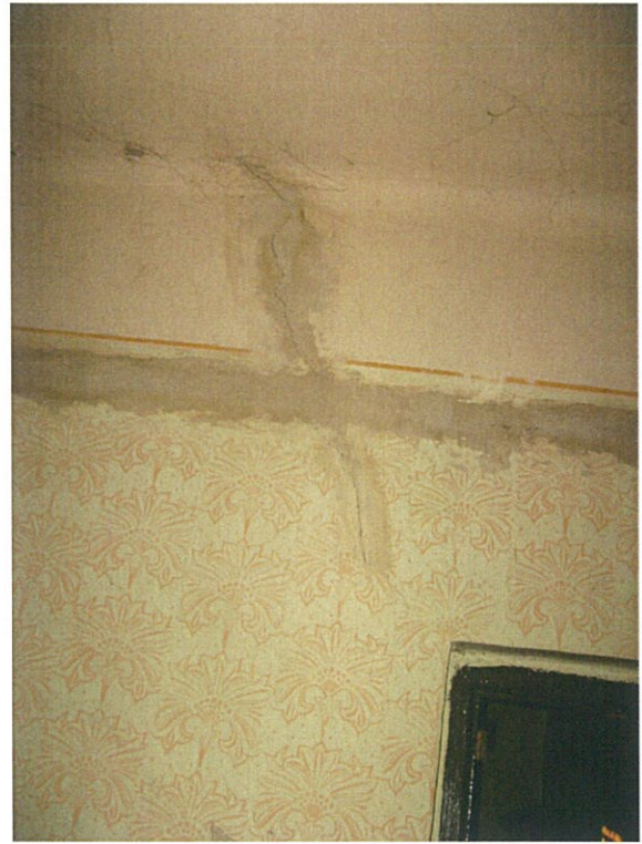
Süllyedésre utaló repedés a két szoba közötti teherhordó falon
